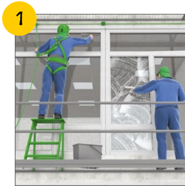
Wir sichern uns an Absturzkanten.
